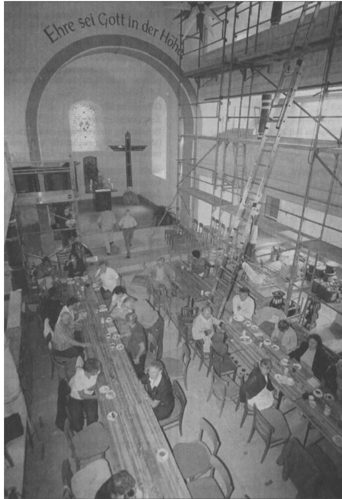
Ehrenamtliche Bauleute beim Sonntagsbrunch, bei dem der schon fertige Altarraum der künftigen Autobahnkirche St. Kilian eingeweiht wurde.
